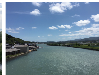
M. 油谷大橋
